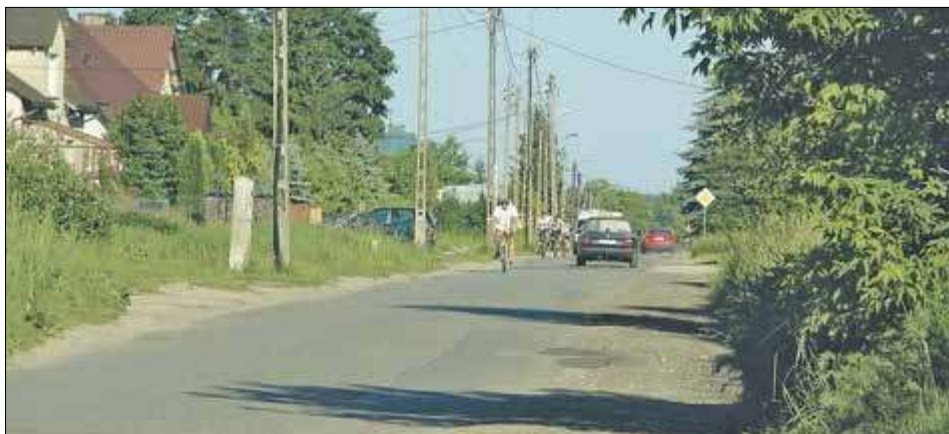
Jak długo ul. Podmiejska będzie pozostawała w sferze marzeń budowlanych magistratu? Teraz plan jej wykonania określono na 2021 rok
