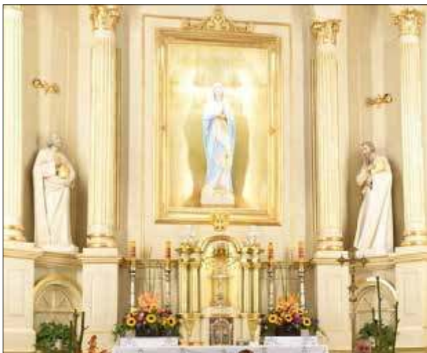
W kościele pw. Narodzenia NMP w Białej Podlaskiej trwają prace konserwatorskie przy odrestaurowaniu ołtarza bocznych. Niedawno zakończyło się też odnawianie ołtarza głównego
