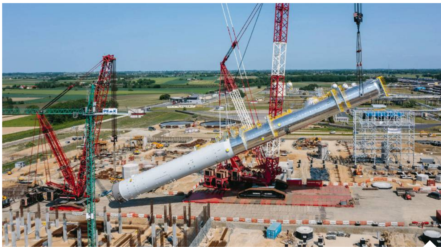
Dzisiaj na placu budowy jest ok. 850 pracowników, ale docelowo może być nawet 13 tys. obcokrajowców | fot. mat. pras./d
