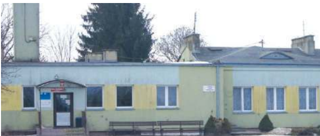
Źródło: Gmina Wierzbica, budynek Szkoły Podstawowej w Święcicy
