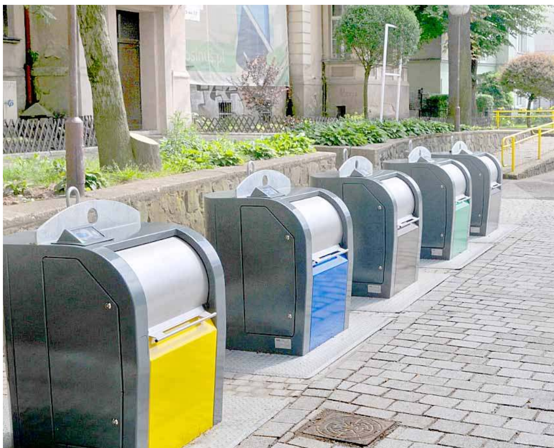
Podziemne gniazdo na odpady segregowane zamontowane w Zielonej Górze. Foto. nj24.pl
