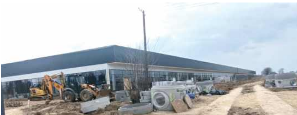
Targowa Park - plac budowy, kwiecień
