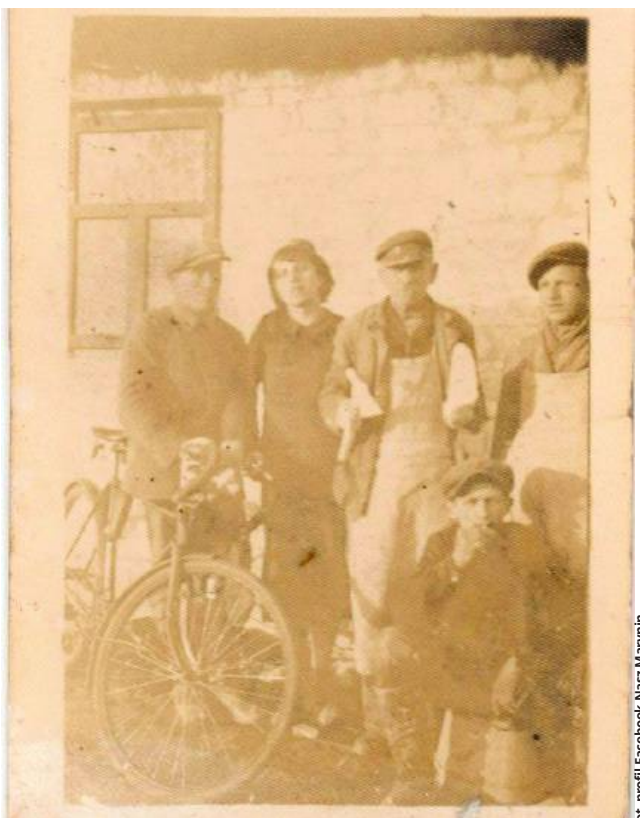
Marianna Szuryga w towarzystwie robotników, którzy budowali zapomnianą już dzisiaj kuźnię
