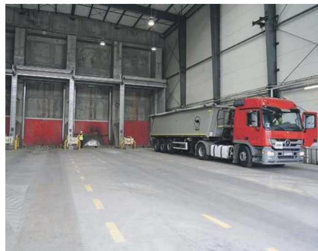
Hala rozładunkowa odpadów komunalnych
