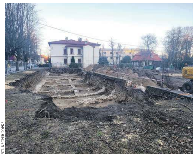
Odkryte fragmenty fundamentów przy LO w Krzeszowicach
