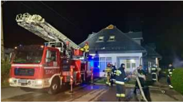
Pożar strawił świeżo wymieniony dach ośrodka
