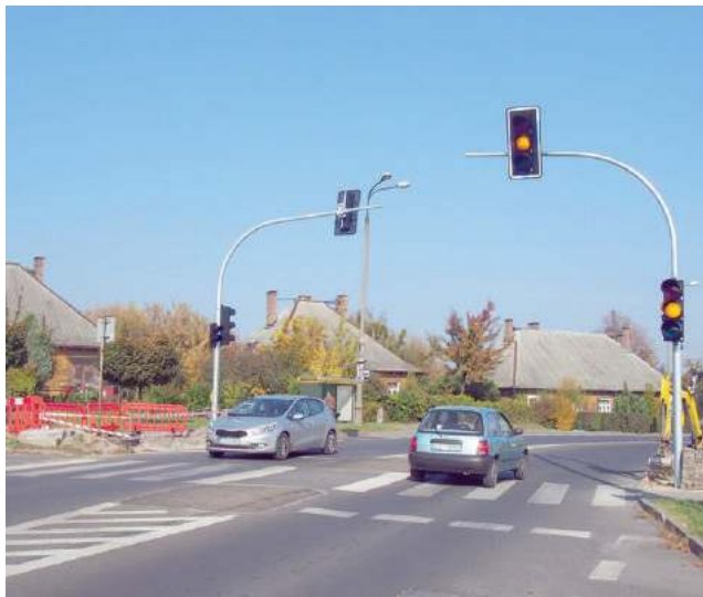
Prace przy przejściu jeszcze trwają
