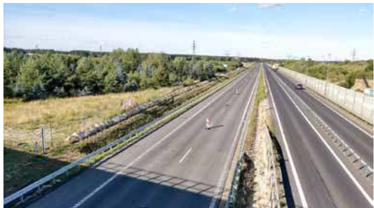
Obwodnica Kobylanki od wczoraj tzn. czwartku (16.7.2020). Kierowcy jeżdżą już po nowej nitce, dotychczasowa zaś będzie teraz remontowana. Zdjęcie: Stowarzyszenie Kobylanka gminą dla swoich mieszkańców
