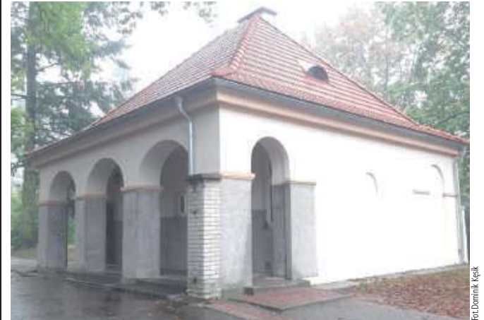
W tym miejscu uczniowie I LO będą mieli własne studio telewizyjne. Budynek „Prokopówki” został zrewitalizowany w ubiegłym roku
