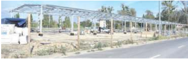
Prace nad rozbudową targowiska idą pełną parą. Tym razem sprzedający zyskają zadaszenie
