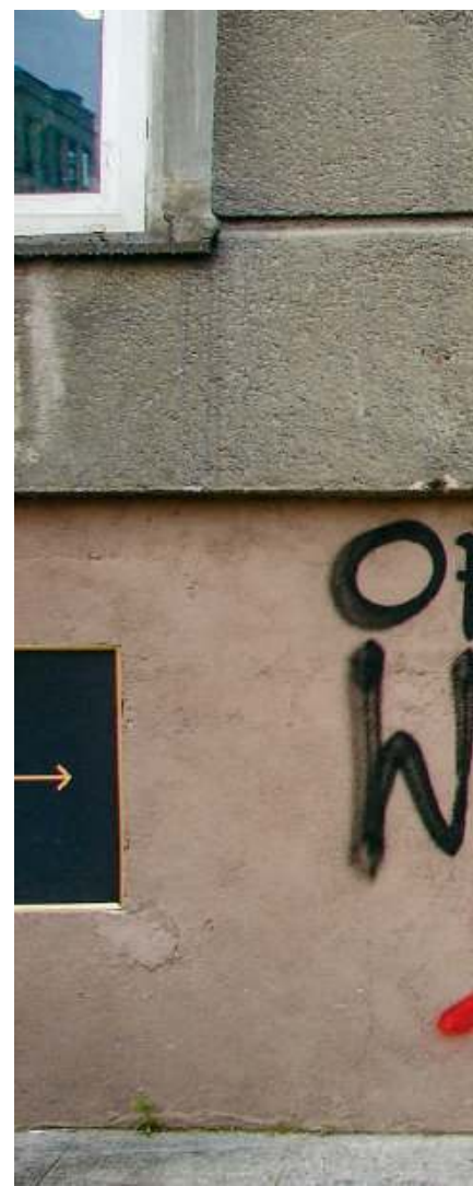
Napis wykonany na fasadzie gmachu PAST-y przy ul. Zielnej
