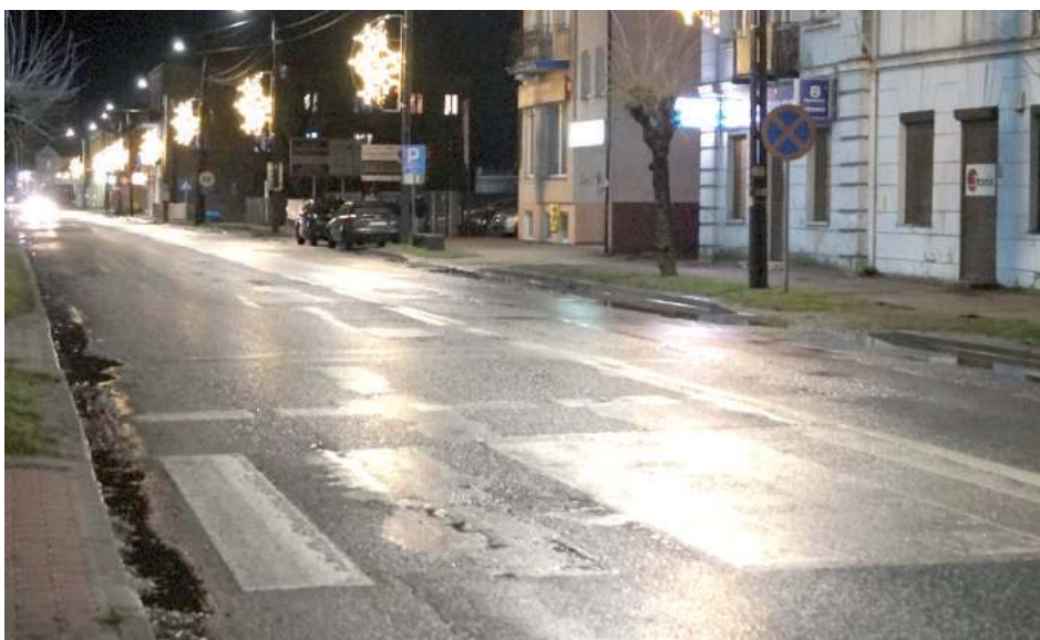
Remontu doczeka się odcinek drogi ul. Lubelskiej
