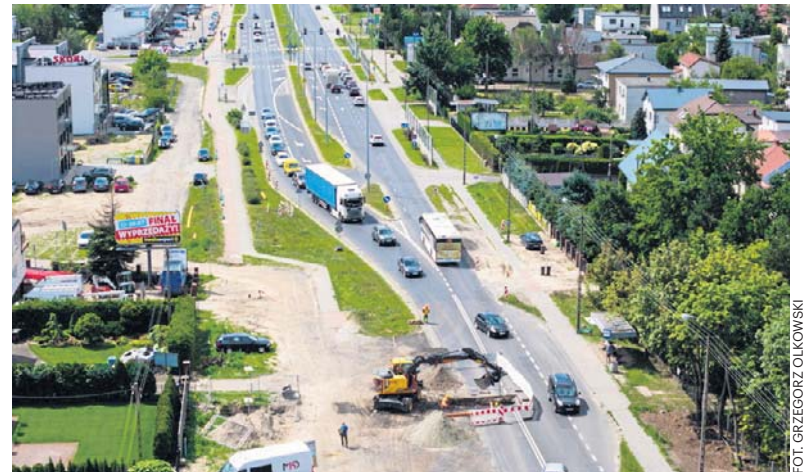
Ulica Olsztyńska na przebudowywanym fragmencie
