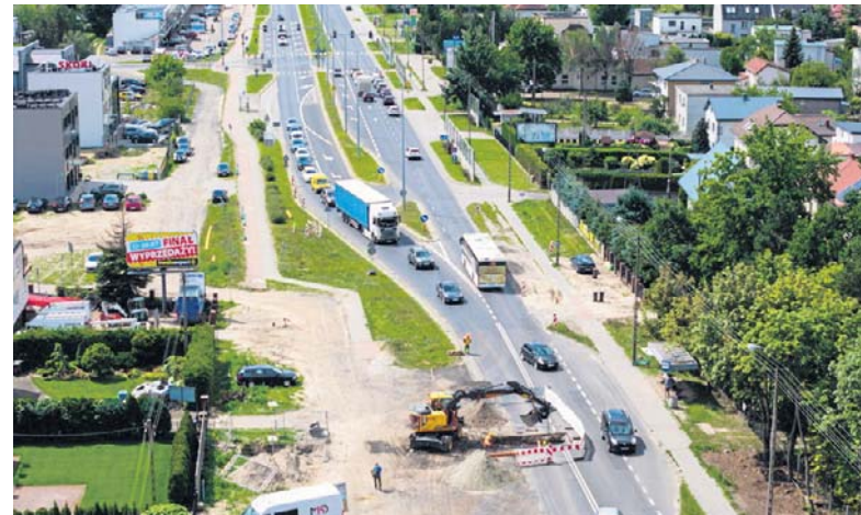
Ulica Olsztyńska na przebudowywanym fragmencie
