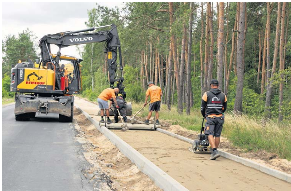
Prace na budowie drogi rowerowej Lubicz-Brzeźno powinny zakończyć się do 30 września
