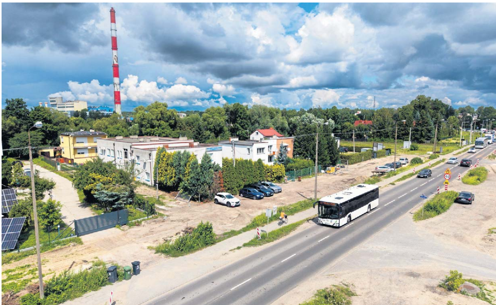
Przebudowa ulicy Olsztyńskiej w Toruniu na zdjęciach z drona. Stan na czwartek, 23 lipca
