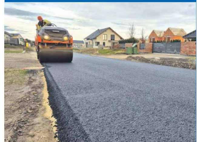
Na ul. Rubinowej wykonywano nawierzchnię bitumiczną.
