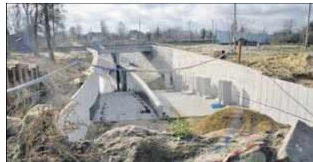
Wydłużone prace przy tworzeniu tunelu pod torami wpłynęły na opóźnienie w realizacji dojazdów do niego
