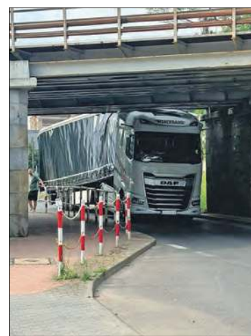
Wiadukt jest pułapką na nieuwważnych kierowców tirów
