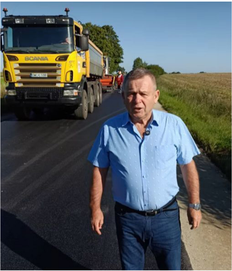
Starosta Jan Janas odwiedził remontowany odcinek drogi powiatowej na terenie gminy Wińsko.
