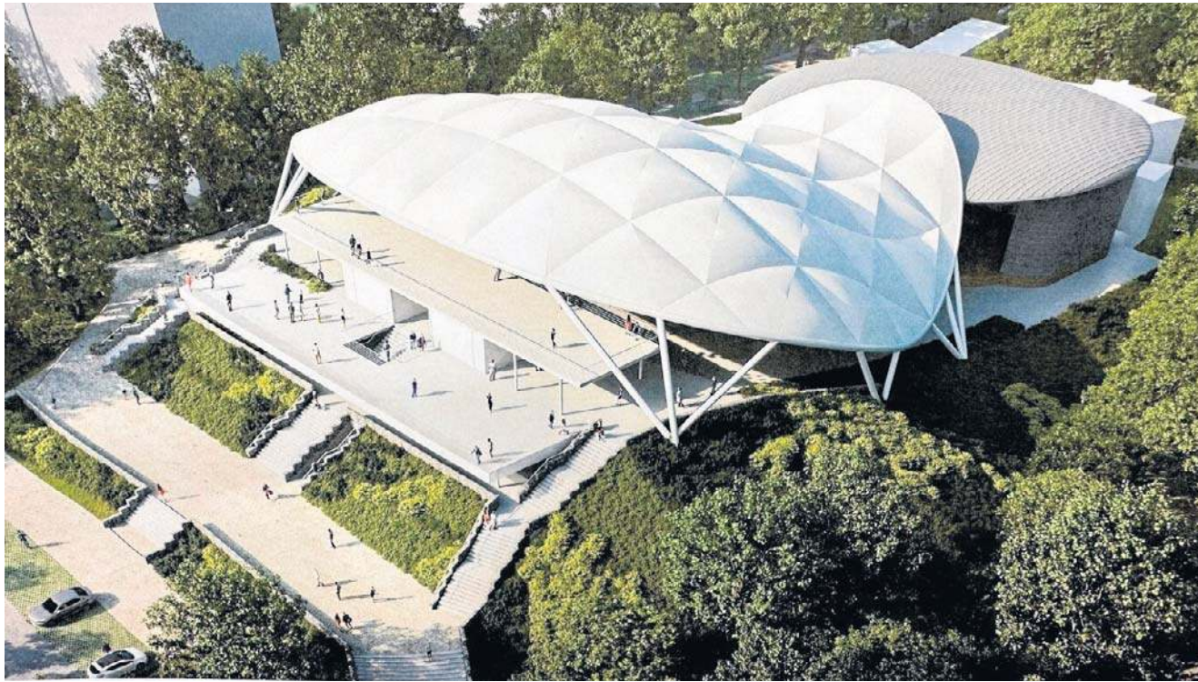
1.06 Zielona Góra ogłosiła przetarg na remont amfiteatru. Umowę z wykonawcą podpisano w grudniu
