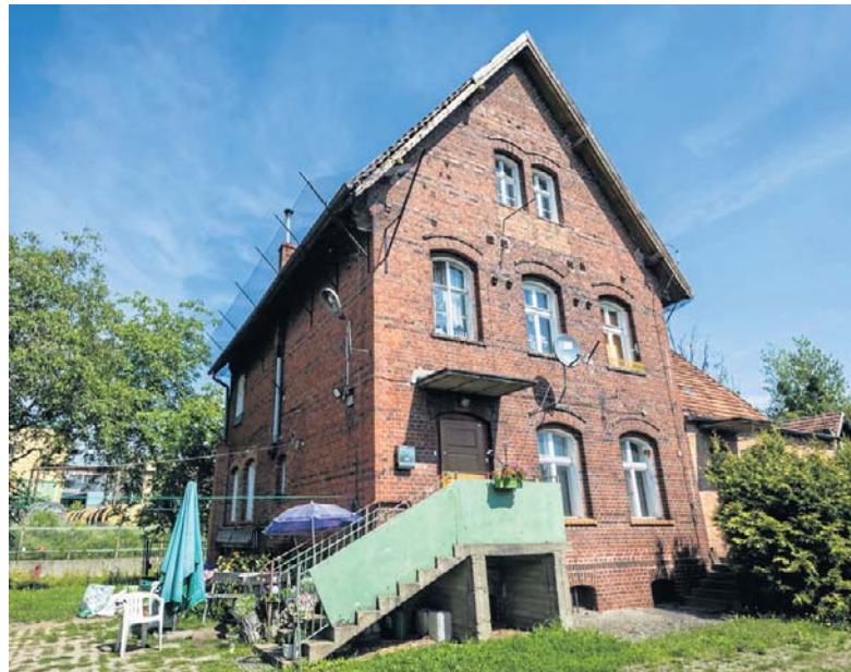
W komentarzach część osób zastanawia się, jaki los spotka budynek, który ma ponad sto lat
