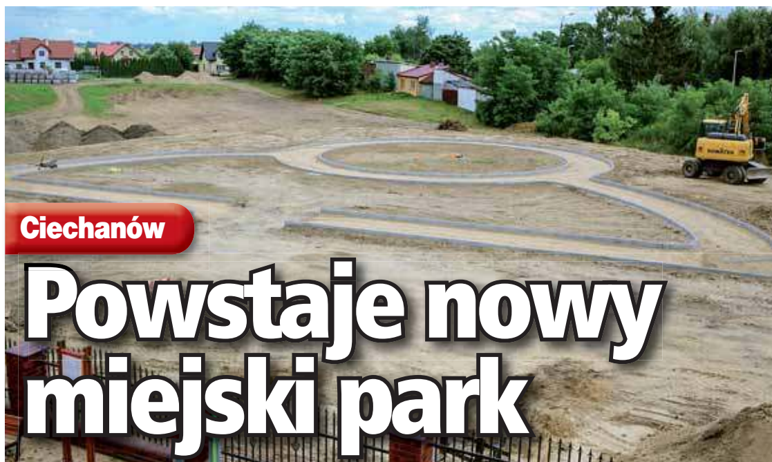
Fragment przyszłego parku na osiedlu Jeziorko
