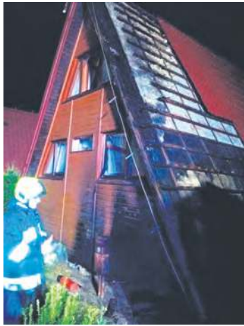
Zdjęto część blachodachówki, by umożliwić dogaszenie pożaru.
