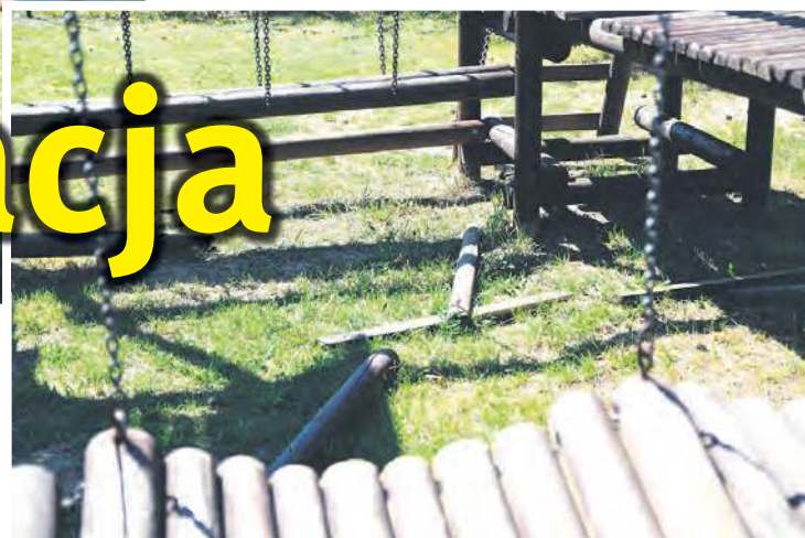
Pod konstrukcją, na której znajdują się zjeżdżalnie, leżą oderwane, drewniane belki.
