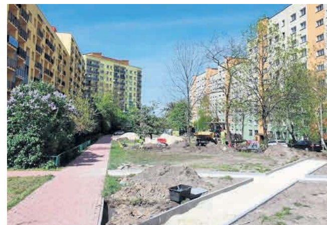
W Dąbrowie Górniczej na osiedlu Mydlce powstaje park, a na os. Kasprzaka będą nowe miejsca parkingowe
