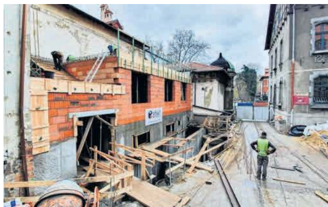
Budowlańcy pracują w teatrze od 2019 roku
