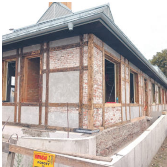
Dworzec w trakcie prac remontowych
