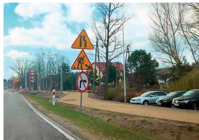
Powstaje blisko 2 km bezpiecznego ciągu pieszo-rowerowego
