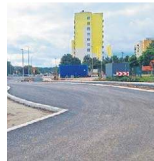
Budowa podzieliła ulicę Owocową na dwie części
