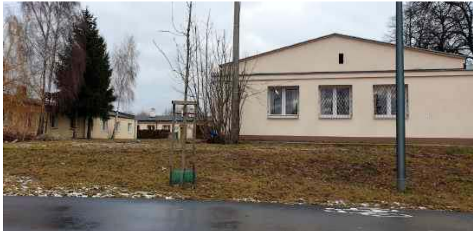
Jednym z najważniejszych przedsięwzięć ma być wyceniana na ok. 8 mln zł modernizacja budynku przy ul. Kolejowej 4 wraz z otoczeniem na potrzeby utworzenia Centrum Aktywności Społecznej
