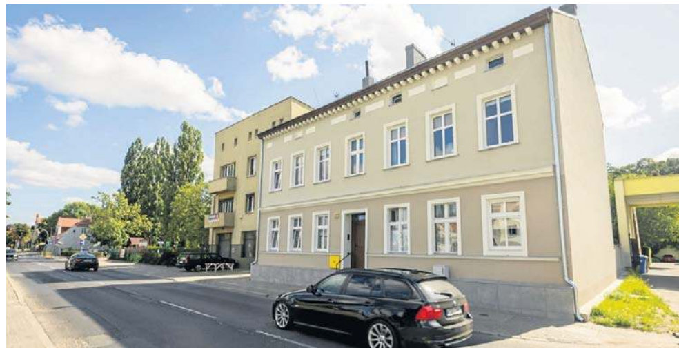
Blisko 130-letnia kamienica przy Toruńskiej 38 zyskała nową elewację. To najdłuższa bydgoska ulica, ma 11 kilometrów długości. Biegnie aż do Łęgnowa Wieś
