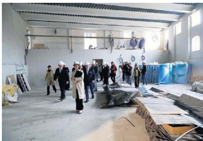
To pomieszczenie będzie salą widowiskową w zabytkowej części Młyna Energii
