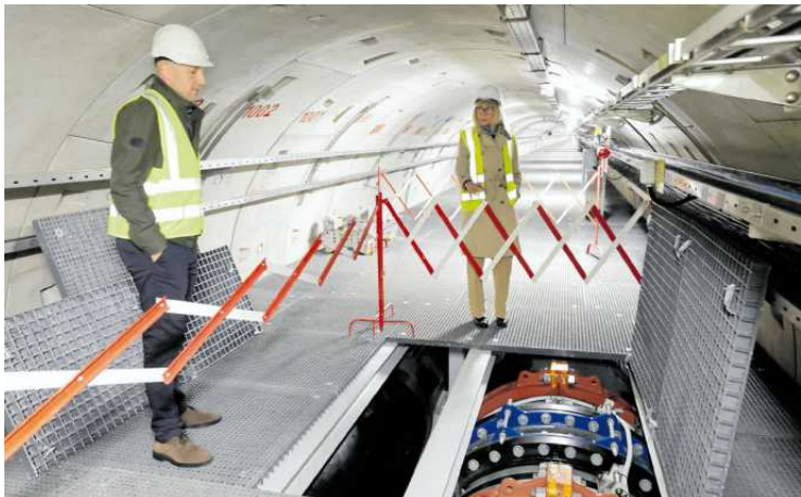
• Kolektor ścieków i nowy rurociąg w tunelu pod dnem Wisły
