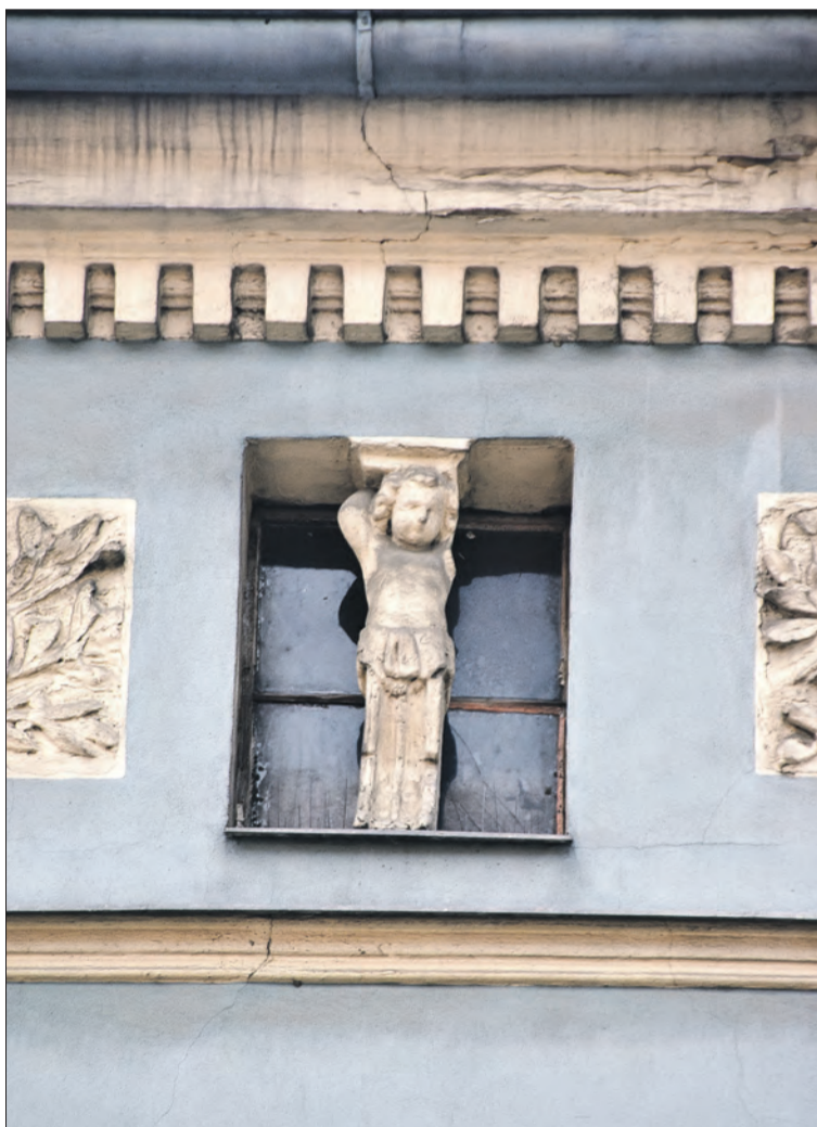
Pseudokariatyda z prudnickiej kamienicy
