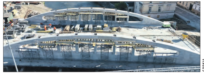
Aktualny stan budowy mostu
