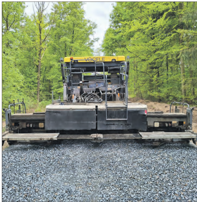
Na kamienny podkład wylany zostanie asfalt
