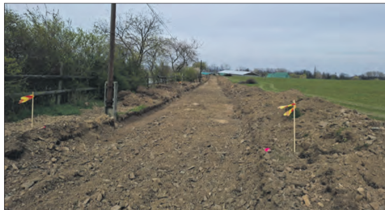
Wzdłuż szosy widać ciąg ścieżki rowerowej
