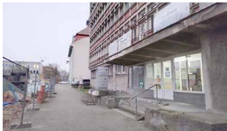
Budynek Cisów póki co pozostaje przykrą wizytówką centrum miasta
