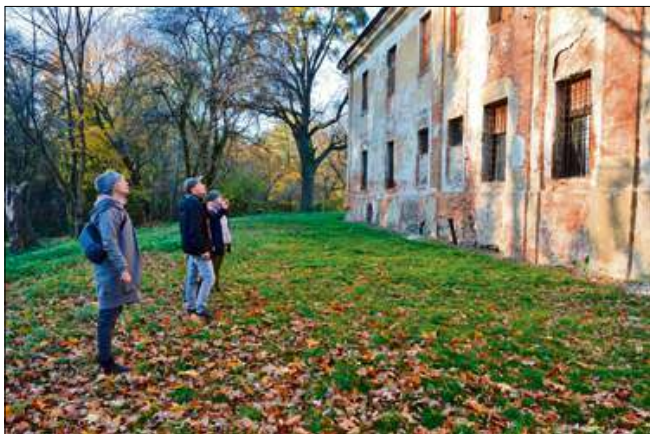
Architekci dokonali wstępnych oględzin konstrukcji obiektu.
