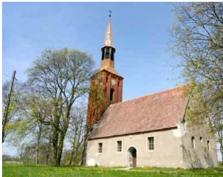
Kościół filialny w Odargowie otrzymał dotację z budżetu gminy na wykonanie projektu remontu dachu kościoła
