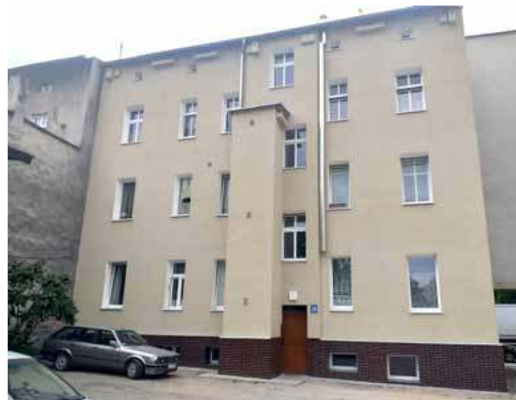
Dzięki dofinansowaniu z Banku Gospodarstwa Krajowego możliwa była renowacja kamienicy przy ul. M. Konopnickiej 28
