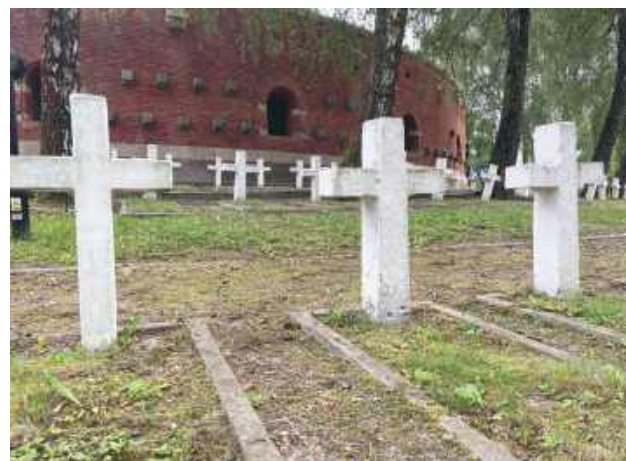
Zakres prac obejmuje demontaż betonowych krzyży i obramowań mogił oraz wykonanie nowych elementów z granitu.
