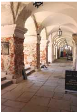
Obecnie prowadzone roboty obejmują kompleksową konserwację podcieni i elewacji. Wykonawca usuwa wtórne warstwy farb, zdegradowane tynki oraz stare zaprawy cementowe.
