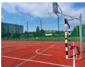
Nowe boisko ma wymiary 15 na 28 m i zostało wyposażone w bezpieczną poliuretanową nawierzchnię. Obiekt umożliwia grę w koszykówkę, siatkówkę oraz tenis ziemny.
