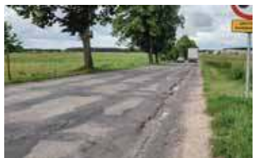
Ulica Gminna która prowadzi do zakładów pracy
