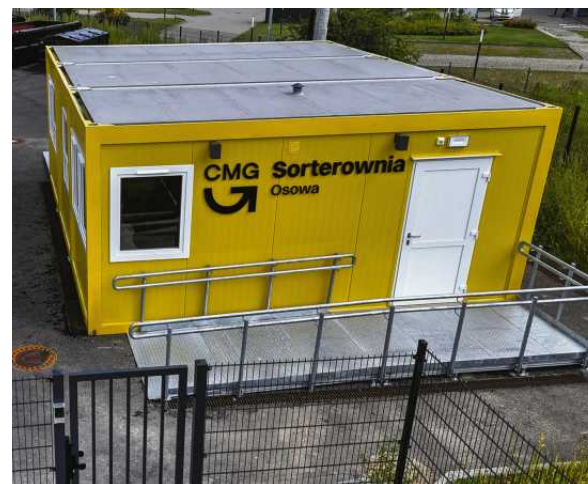
fot. Dyrekcja Rozbudowy Miasta Gdańska.
