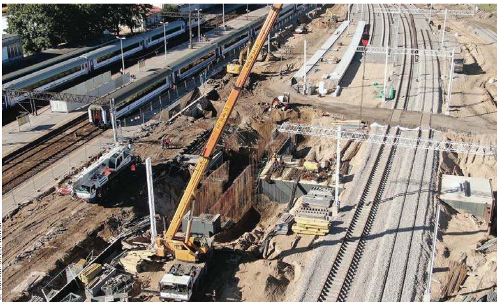
Modernizacja stacji Olsztyn Główny idzie pełną parą
