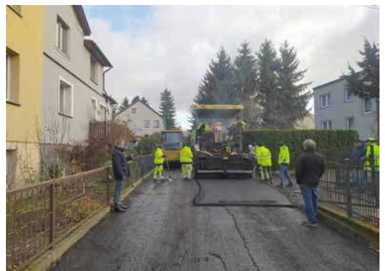
Prace zostały przeprowadzone we wtorek
