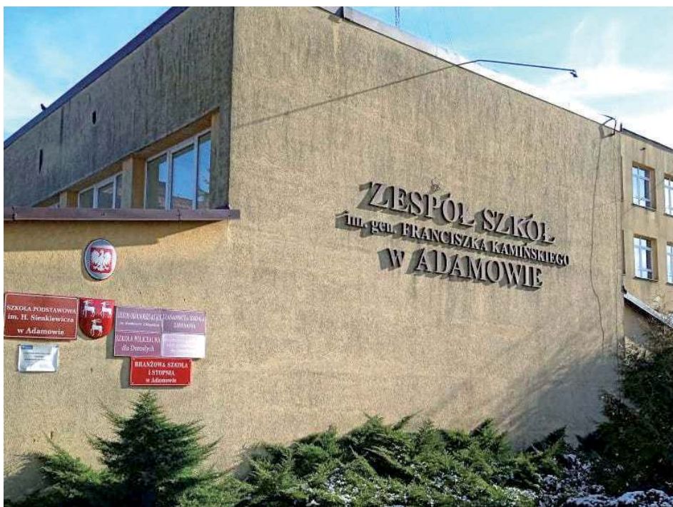
Szkołę w Adamowie czeka w tym roku dużo zmian. W Zespole Szkół zostanie utworzone Technikum, a sam budynek przejdzie remont. Ściany zyskają nową elewację, zaś sala gimnastyczna przejdzie gruntowny remont i wymianę dachu
