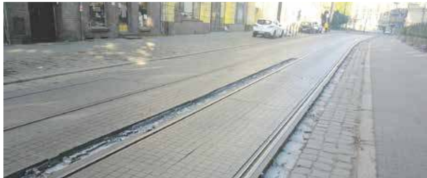
Uszkodzenia wreszcie znikną z Katowickiej
