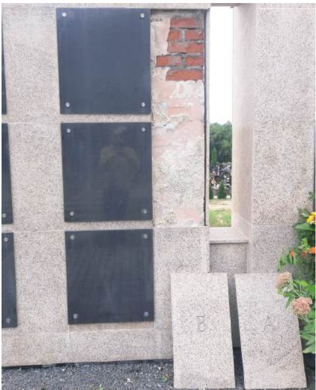
Tak wyglądało kolumbarium w 2021 r. Obecnie przy całej budowie nie ma płytek. Nad modernizacją miejsca jeszcze poczekamy
