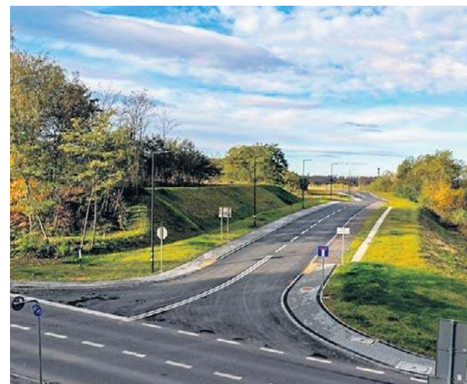
Na terenie inwestycyjnym po zrehabilitowanej hałdzie wybudowano wewnętrzną drogę dojazdową
