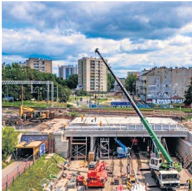
Wiadukt będzie zamknięty od 8 kwietnia do 22 maja. Powodem są prace na torowisku tramwajowym
