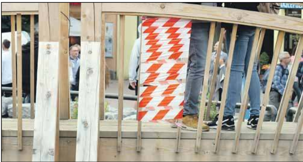
Kilka chwil po upadku chłopca dziurę w poręczy zabezpieczono białą-czerwoną taśmą.
