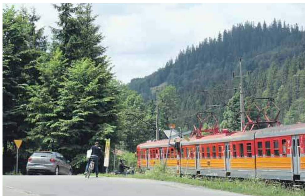
Przejazd kolejowy w Poroninie generuje szereg niebezpiecznych sytuacji. To obecnie jedyny dojazd do Zakopanego dla blisko 1,5 tys. mieszkańców.
