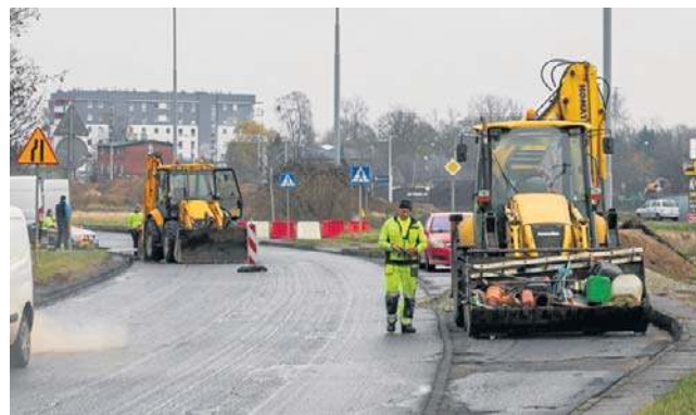
Prace remontowe rozpoczęto równolegle na ulicach Andersa i Akademickiej.
