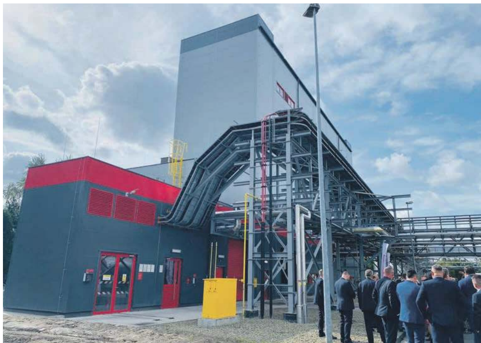
Budowa instalacji do produkcji biodiesla kosztowała 127,5 mln zł
