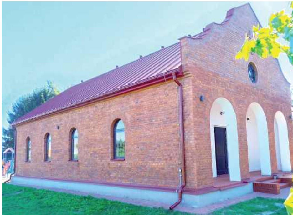
W budynku kaplicy widać istotne zmiany jak m.in. nowe pokrycie dachowe
