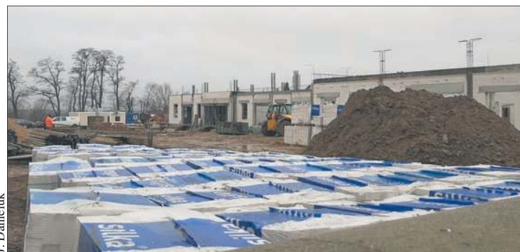
Budowa żłobka pomiędzy ulicami Polną i Kazimierza Wielkiego
