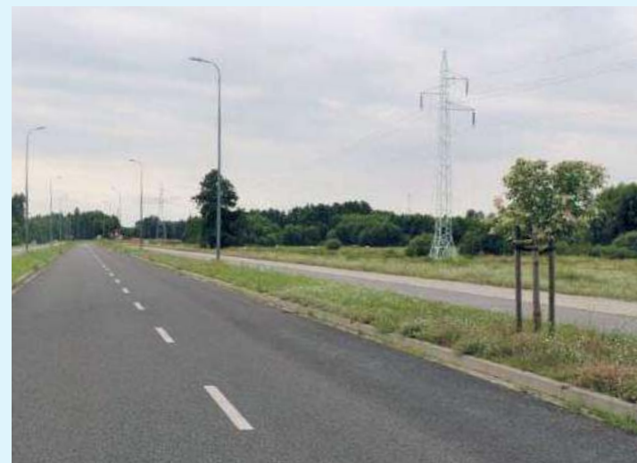
Niedługo zostanie ogłoszony przetarg na nasadzenia (fot. UM Nowa Sól)
