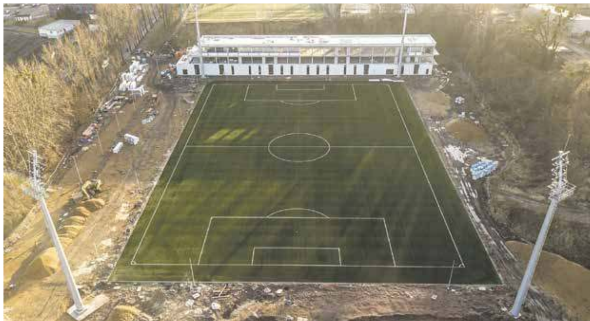
Nowy stadion powstaje nieopodal starego
