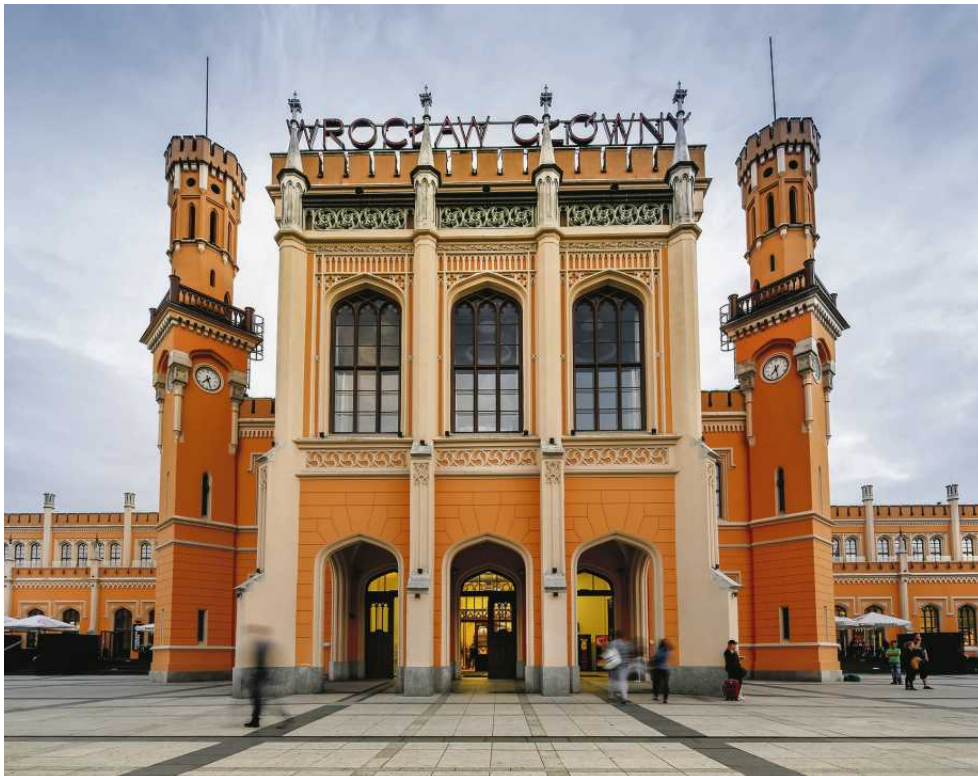
Dworzec PKP Wrocław Główny
